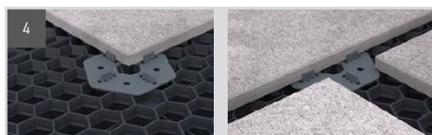
Die Verlegung des Plattenbelags erfolgt frei auf der Fläche. Für einheitliche Fugenabstände legen Sie TRIAS WABIC X-Pads unter die Plattenstöße. Falls zusätzliche Stellfüße erforderlich sind, können diese nachträglich eingesetzt werden: Einfach das Board abnehmen, die Stellfüße einsetzen, das Board wieder auflegen und die Stellfüße in der Höhe anpassen.
